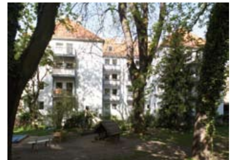
Die neuen Balkone erhöhen den Wohnwert der 1950er Jahre Bauten erheblich.
